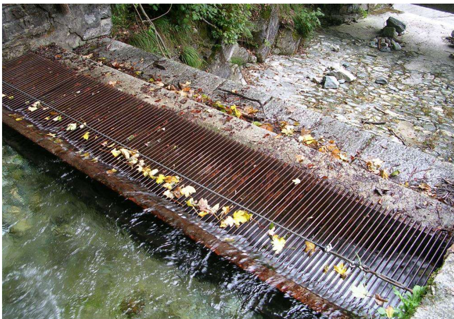
Foto 4 - Presa a trappola (rio Giulian), tipologia caratteristica delle derivazioni dell'impianto di Calcinere
