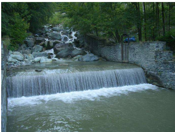
Foto 8 – Opera di presa sul fiume Po (sx, da valle e dx, da monte).
