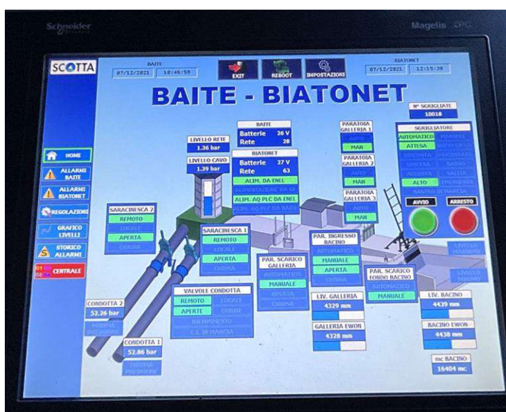
Foto 21 – Sistema di controllo al bacino Biatonnet
