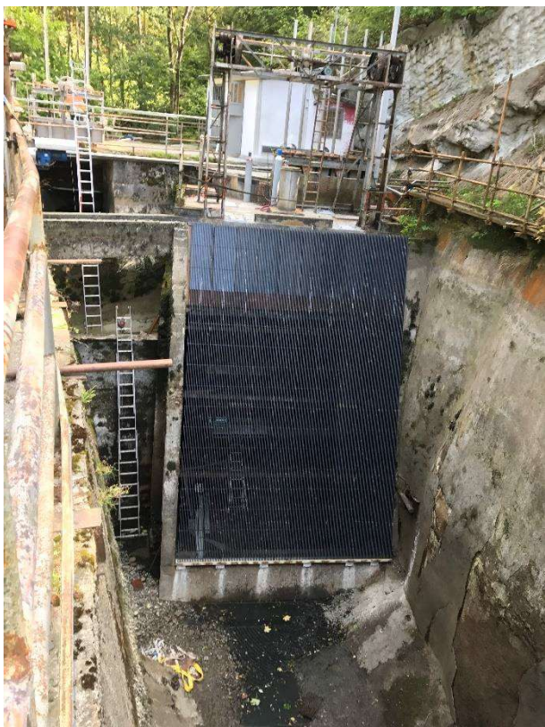
Foto 18 – Il nuovo sgrigliatore in fase di installazione (foto a sn 2017) e con impianto in funzione (foto a dx 2021)
