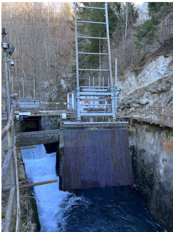
Foto 18 – Il nuovo sgrigliatore in fase di installazione (foto a sn 2017) e con impianto in funzione (foto a dx 2021)
