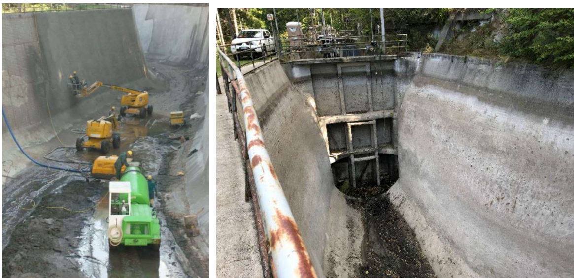
Foto 20 – Lavori al bacino Biatonnet: a sin, i ripristini del 2007, a dx il setto centrale del bacino, in vista durante la sostituzione dello sgrigliatore nel 2017
