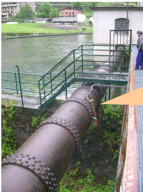
Foto 31 - Sensore di velocità a ultrasuoni installato su una delle condotte
