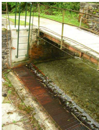
Foto 15 – Opera di presa sul t. Frassaia (sx, vista laterale e dx, da valle).
