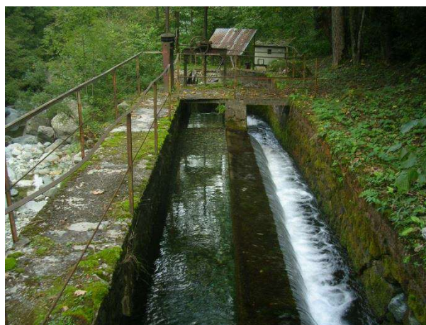
Foto 13 – Presa sul t. Lenta (sx, vista laterale) e sfioratore laterale di ingresso della portata nel canale di gronda (dx, da monte).
