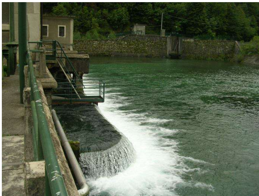
Foto 28 - Scarico della centrale nel bacino per sfioro da una vasca di forma allungata che si sviluppa al di sotto delle condotte forzate.
