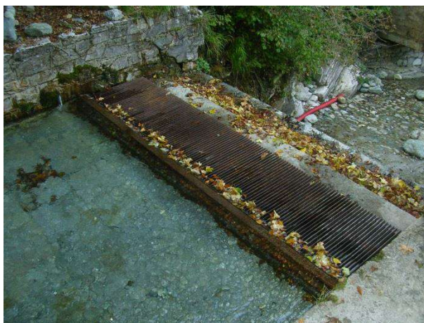
Foto 9 –Opera di presa sul rio Giulian (sx, vista da valle e dx, vista da monte).
