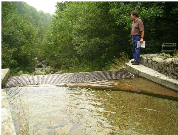
Foto 6 – Opera di presa sul rio Combe (sx, da monte) e dispositivo di rilascio del DMV (dx, da monte).
