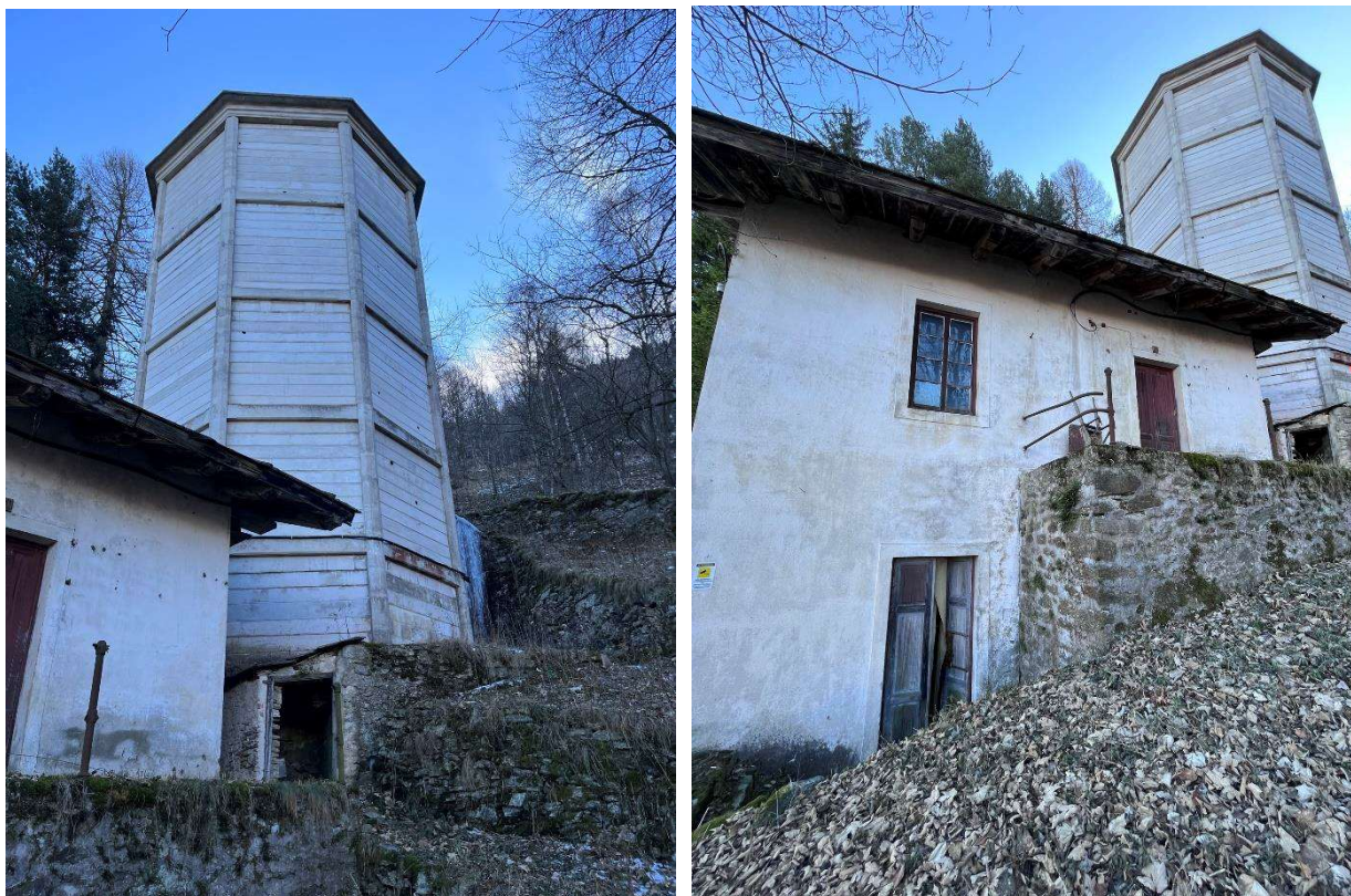
Foto 22 – il pozzo piezometrico e l'edificio con le valvole di testa condotta.
