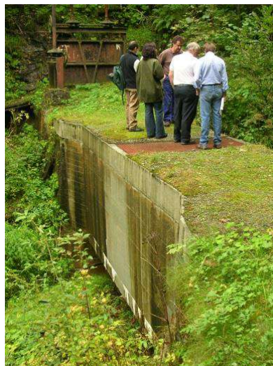
Foto 14 – Presa sul t. Cugnet (sx, da valle) e canale di adduzione in un tratto di attraversamento di un impluvio (dx, da valle).
