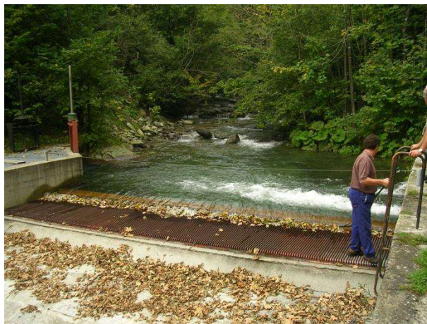
Foto 7 – Opera di presa sul t. Tossiet (sx, vista laterale e dx, vista da valle).
