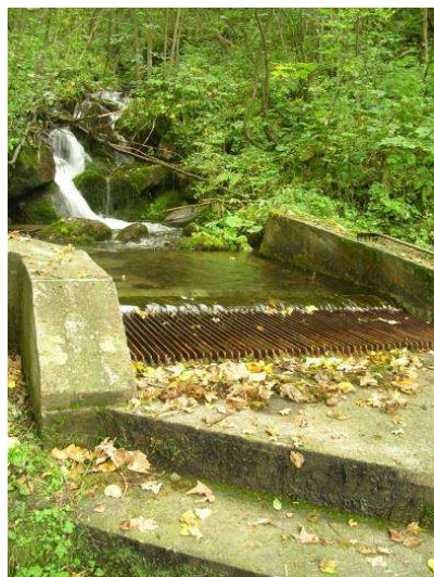
Foto 14 – Presa sul t. Cugnet (sx, da valle) e canale di adduzione in un tratto di attraversamento di un impluvio (dx, da valle).
