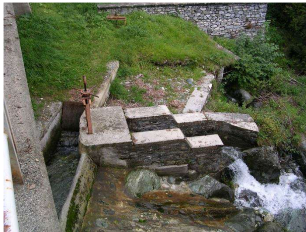
Foto 6 – Opera di presa sul rio Combe (sx, da monte) e dispositivo di rilascio del DMV (dx, da monte).
